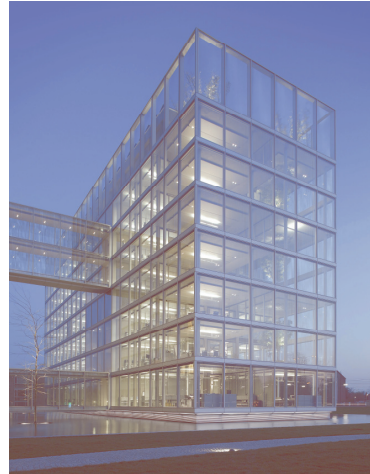
Bild 2: Hauptverwaltung Gelsenwasser AG
